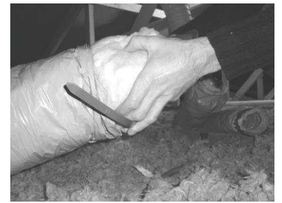
Positionner l'isolant jusqu'à la rainure A
