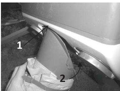
Cliper les piquages en respectant l'ordre 1 puis 2 (cuisine D125, sanitaires D80). Montage à 90° (8) ou en ligne (8bis)
