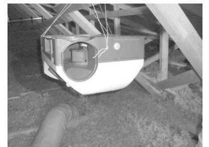
Suspendre le groupe à l'aide la cordelette.
