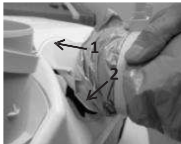
Cliper les piquages en respectant l'ordre 1 puis 2 (cuisine D125, sanitaires D80). Montage à 90° (8) ou en ligne (8bis)
