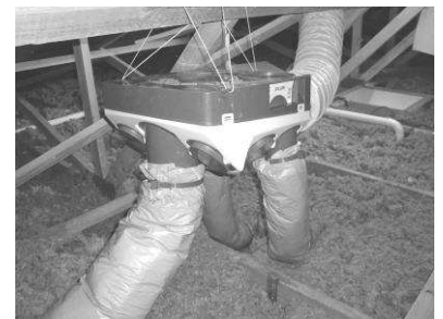
Votre caisson est installé
